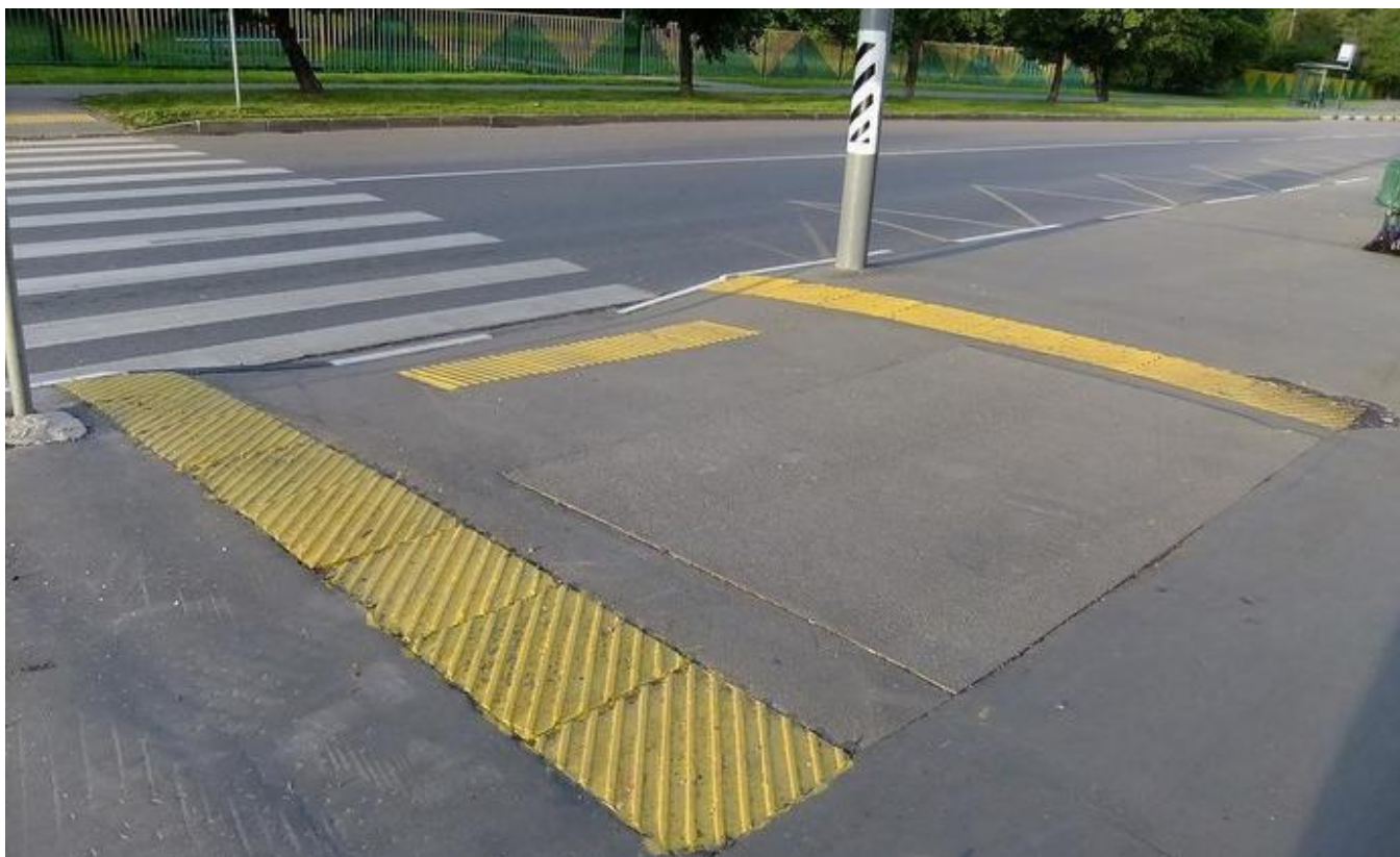
Пример укладки тактильной плитки для обозначения пешеходного перехода
